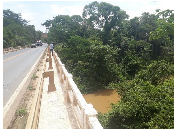
Figura 8: coleta no ponto 01 – montante da cidade de Patos de Minas na BR 365 – rio Paranaíba. Época seca
